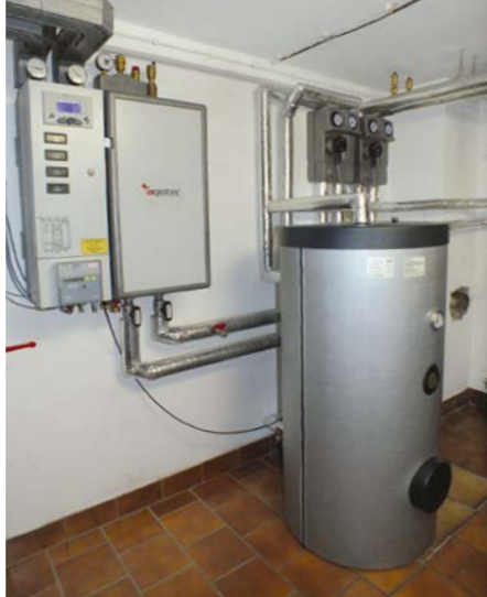
Die Standardübergabestation in einem Einfamilienhaus in der Hubertusstraße ist wandhängend montiert und absolut platzsparend. Die Leistung beträgt 15 kW.
