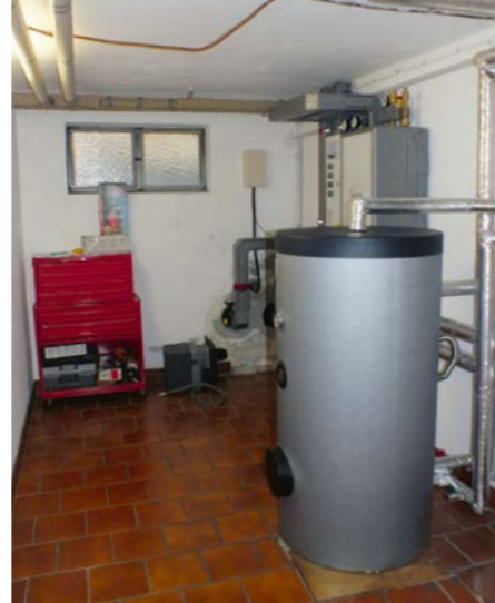
Die Standardübergabestation in einem Einfamilienhaus in der Hubertusstraße ist wandhängend montiert und absolut platzsparend. Die Leistung beträgt 15 kW.
